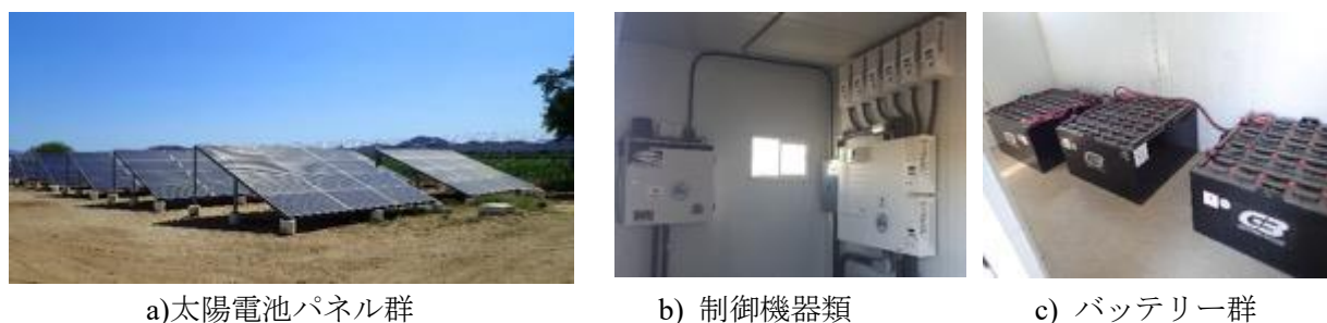
図13 農家実証モデルに導入された独立型太陽光発電システムの主要機器類
